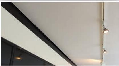
**SPANNDECKE INDIVIDUELL** - Textile Stoffbahnen werden glatt auf eine Unterkonstruktion abgespannt um technische Einrichtungen zu verdecken. Durch eine individuelle Verarbeitung können Brandmeldeanlagen, Heizungseinlässe, Wandanschlüsse und vieles mehr sauber eingearbeitet werden, um ein klares, einheitliches und neutrales Gesamtbild zu erhalten.
