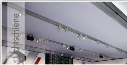
**STRETCH-HIMMEL** - Textile Stoffbahnen werden in die Kedernut eingezogen, um die Unterkonstruktion sowie technische Einrichtungen nicht nur zu verdecken, sondern auch, um ein klares, geradliniges und faltenfreies Gesamtbild zu schaffen.
